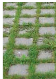
Pavés joints engazonnés
